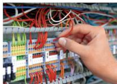
Čas pro celkovou instalaci se zkrátí a minimalizují se chyby díky efektivní push-in technologii.
